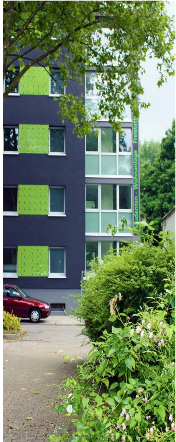
Essen, Freistattstraße: Außenansicht des neuen Wohnheims
